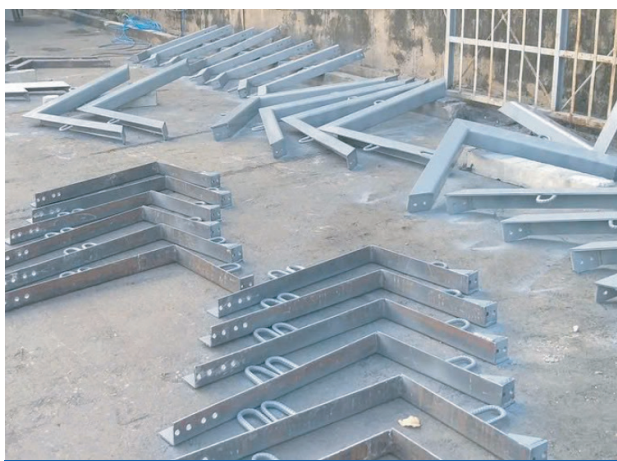
■ Gông lắp xưởng cột nhà xưởng CN
