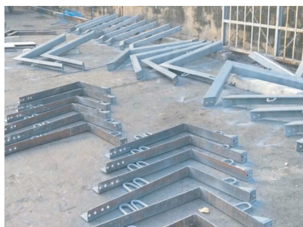
■ Gông lắp xưởng cột nhà xưởng CN
