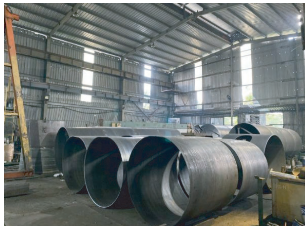
■ Ống cọc nhồi D1200
